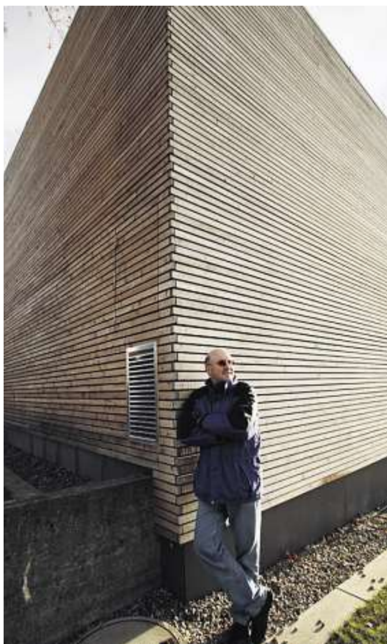
Das Kirchgemeindehaus Melchenbühl (im Bild: Urs Boo, Sigrüst) wurde nach Minergie-Kriterien saniert
