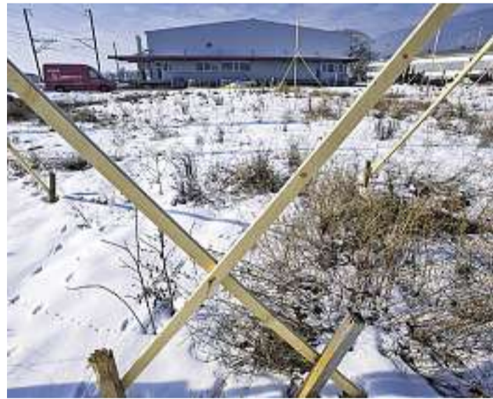
Profilstangen zwischen Bahnlinie und Lagerhalle: Hier soll die zweistöckige Moschee in Grenchen zu stehen kommen
