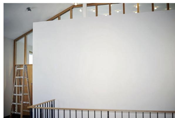
Foyer des Neubaus.
