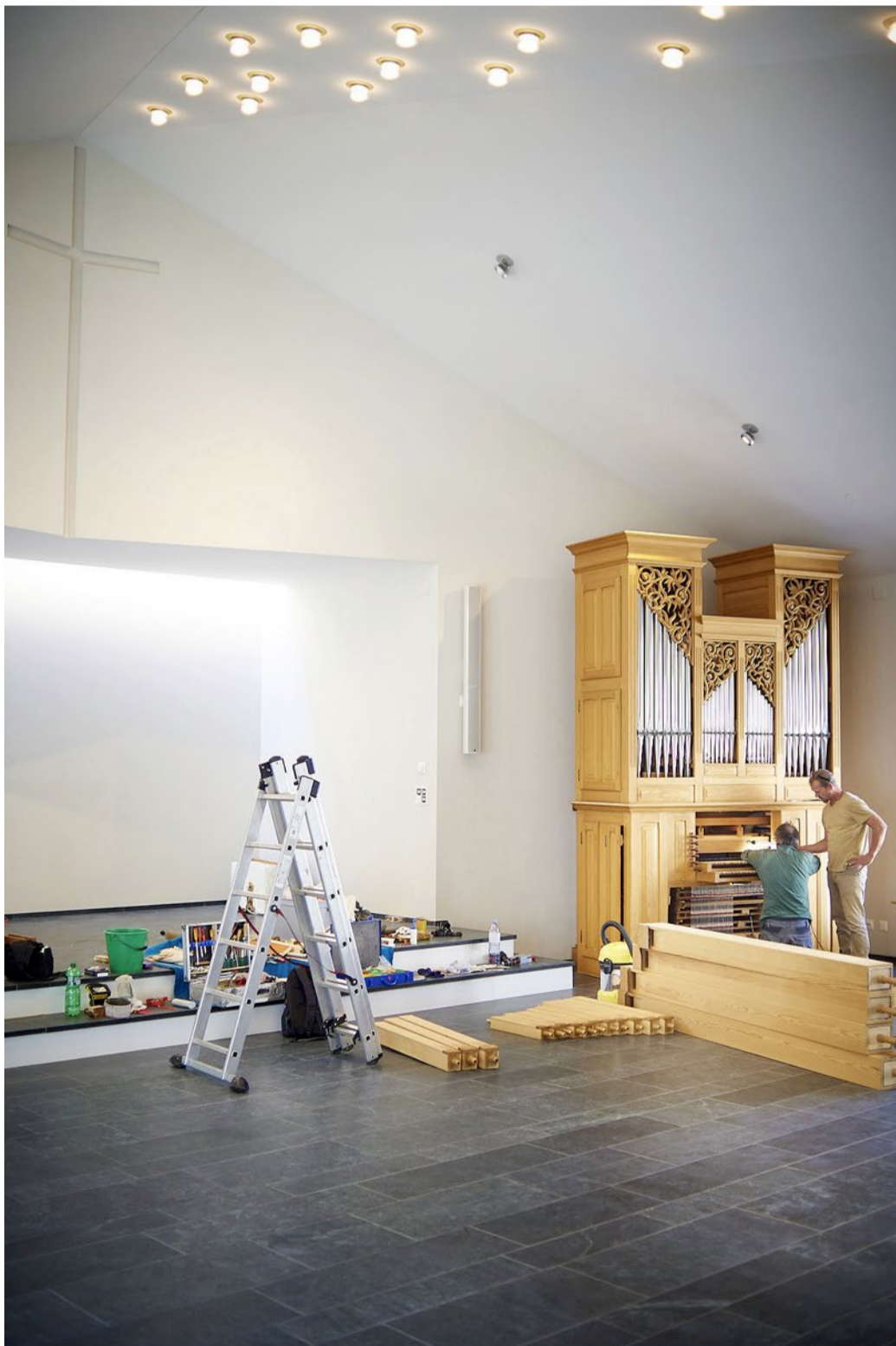
Im hellen Kirchenraum ist noch der Orgelbauer zugange.
