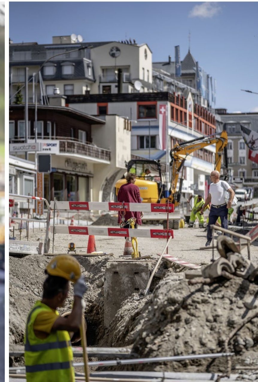
Die Arbeiter verlegen insgesamt 3,5 Kilometer Rohre.
