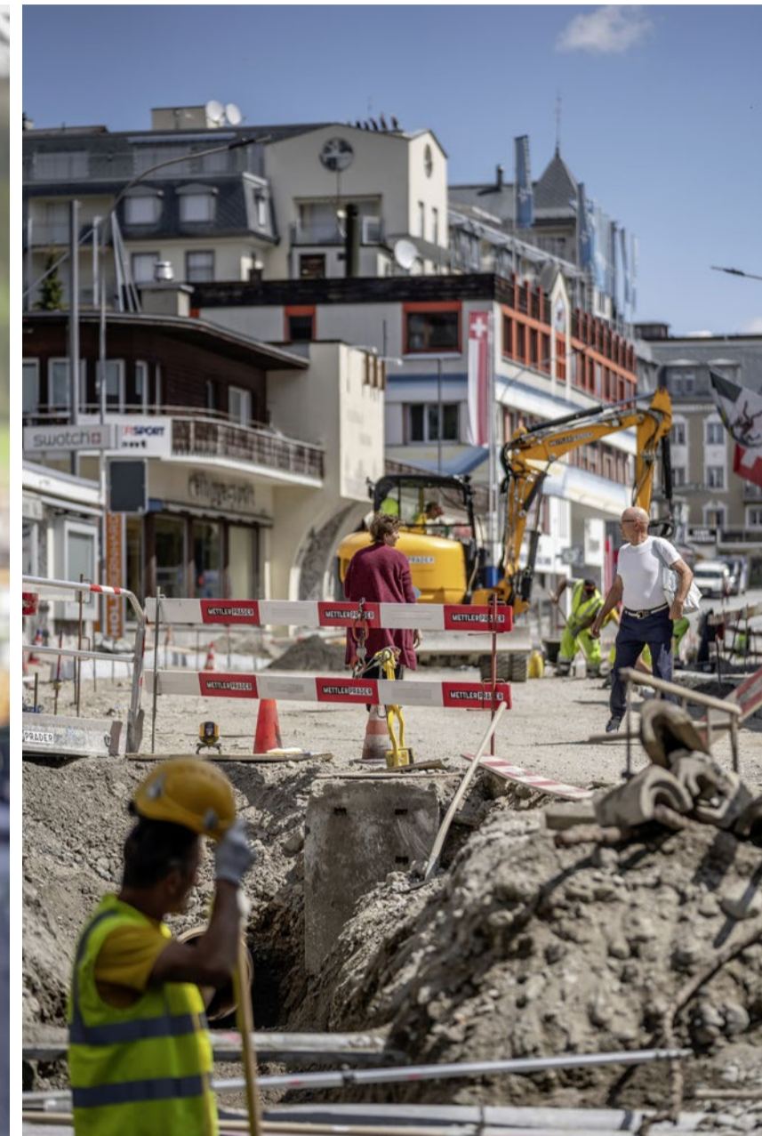
Die Arbeiter verlegen insgesamt 3,5 Kilometer Rohre.
