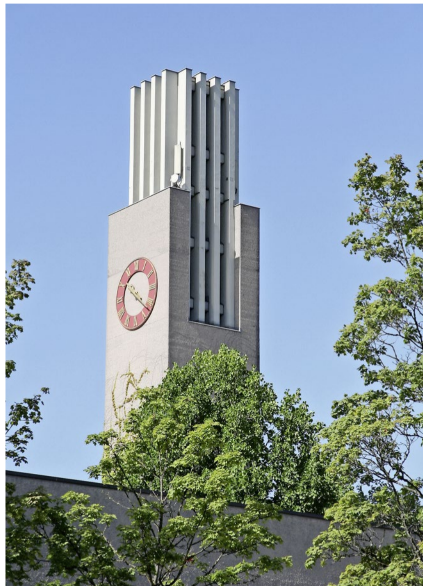
Handyantenne auf dem Kirchturm in Zürich-Affoltern. Foto: Wikimedia/Bernasconi
