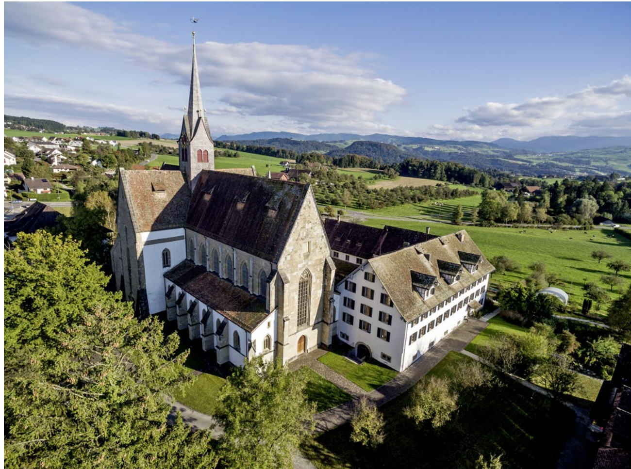
Bald eine Baustelle: Das Kloster Kappel mit Seminarhotel und Bildungshaus
