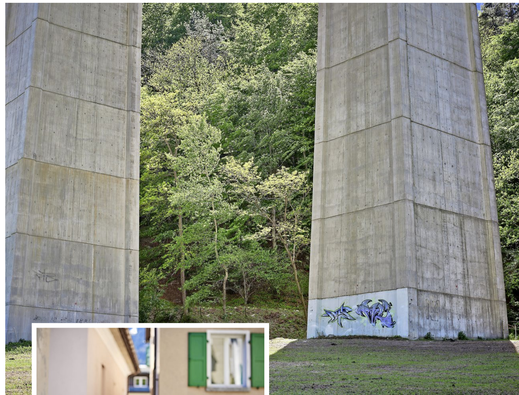
Laub trifft Beton: zwischen Chironico und Cavagnago
