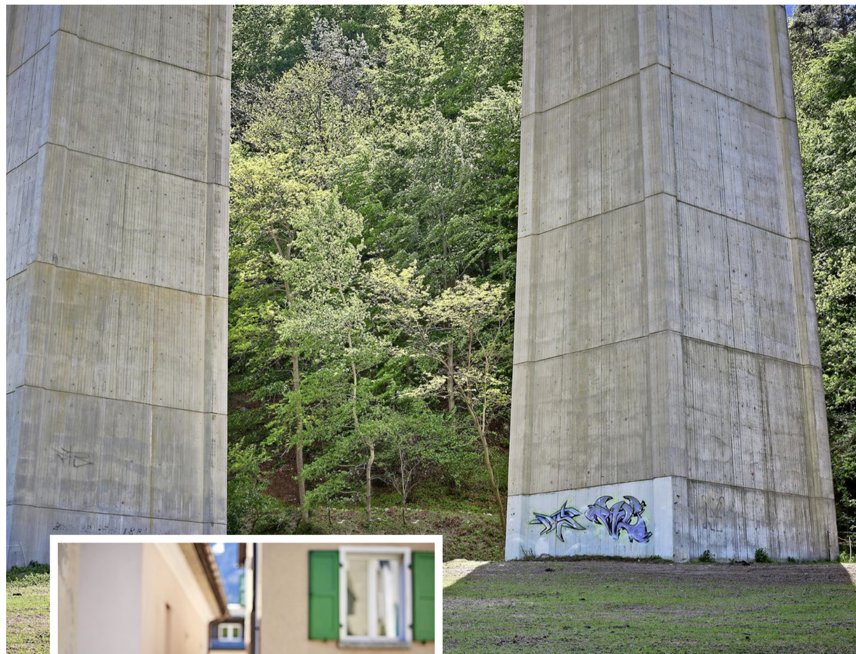
Laub trifft Beton: zwischen Chironico und Cavagnago
