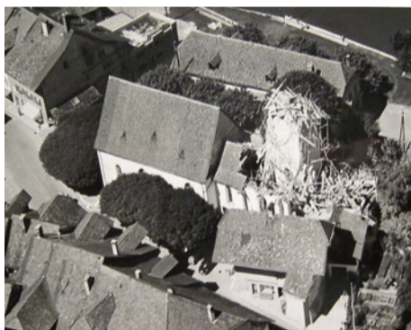
Der Turmsturz, der 1963 Büren erschütterte
